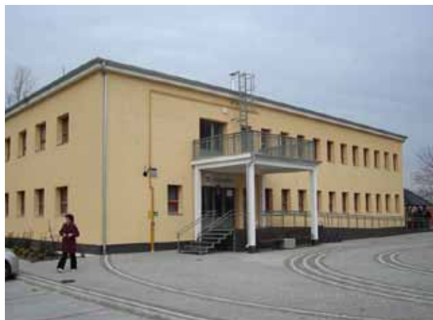
7d. kép: „B” épület bejárata
