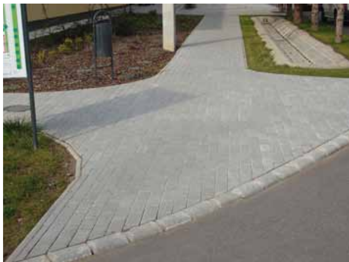
5e-f. kép: Esélycentrum telken belüli járdák
